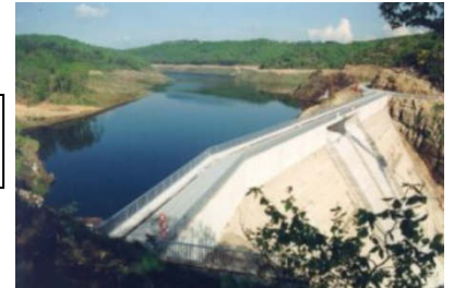
Barrage de la SEP
